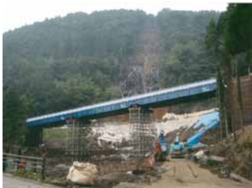
上部工架設完了
