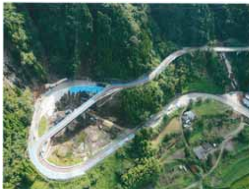
迂回路設置工事完成写真
