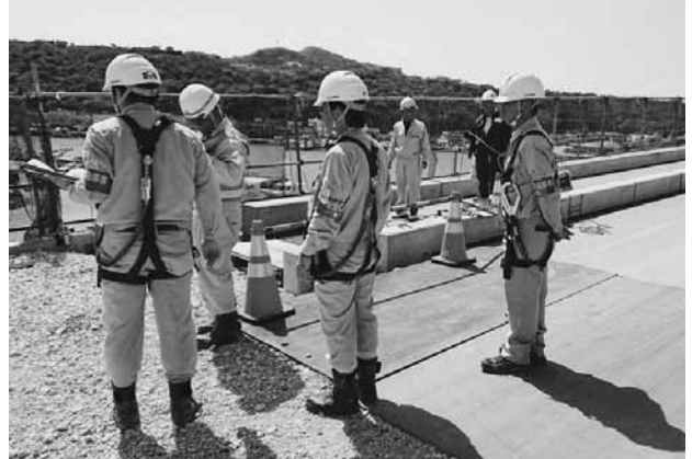
高所作業場をチェック（3月20日）
