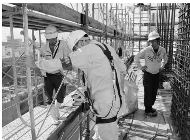
足場等をチェックした（2月13日）
