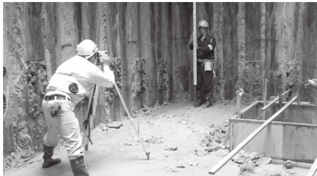
現在手掛けている新名護幹線一部地中化工事(管路布設)の現場。河川伏越しのため、推進工事を採用。発進立坑工事の施工状況です。
